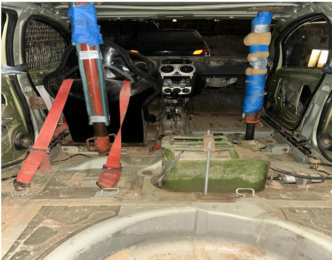
Les deux étais doivent être reliés par une barre au dessus du toit qui sera boulonnée avec les étais.
